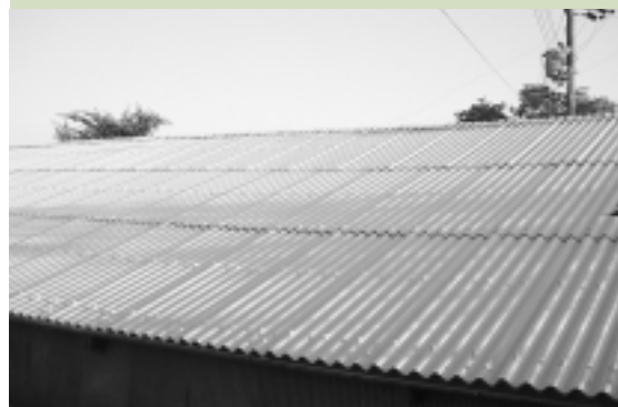
7 6. 遮熱塗料(トップコート) 1回目
