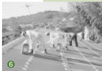
7 6. 遮熱塗料(トップコート) 1回目
