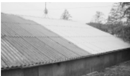
3 高圧洗浄途中(右半分完了)
