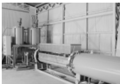
不燃処理設備： 奥の注入缶で減圧・加圧注入を行い、 木材に不燃薬剤を浸透させる
