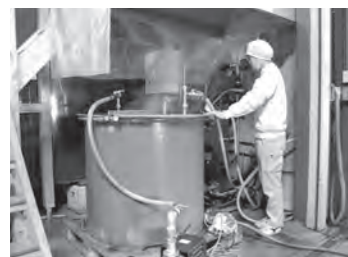
酒を熱処理するプレートヒーター簡易ユニット
