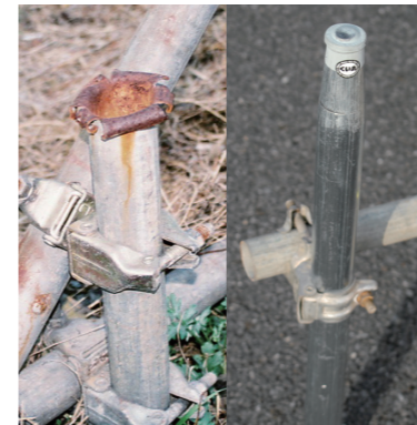
足場管と「くい丸」の施工状態の比較
