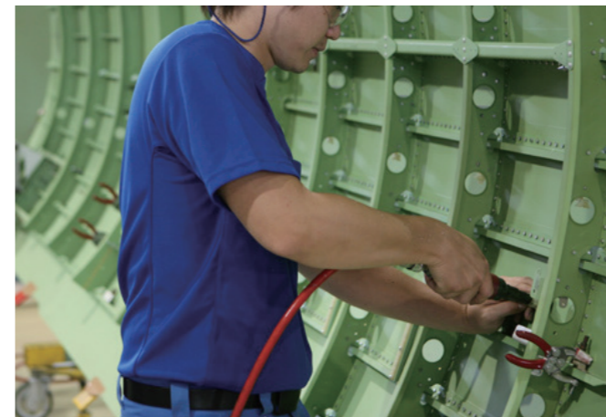
超軽量・小型化を実現した航空機組立用エアツール
